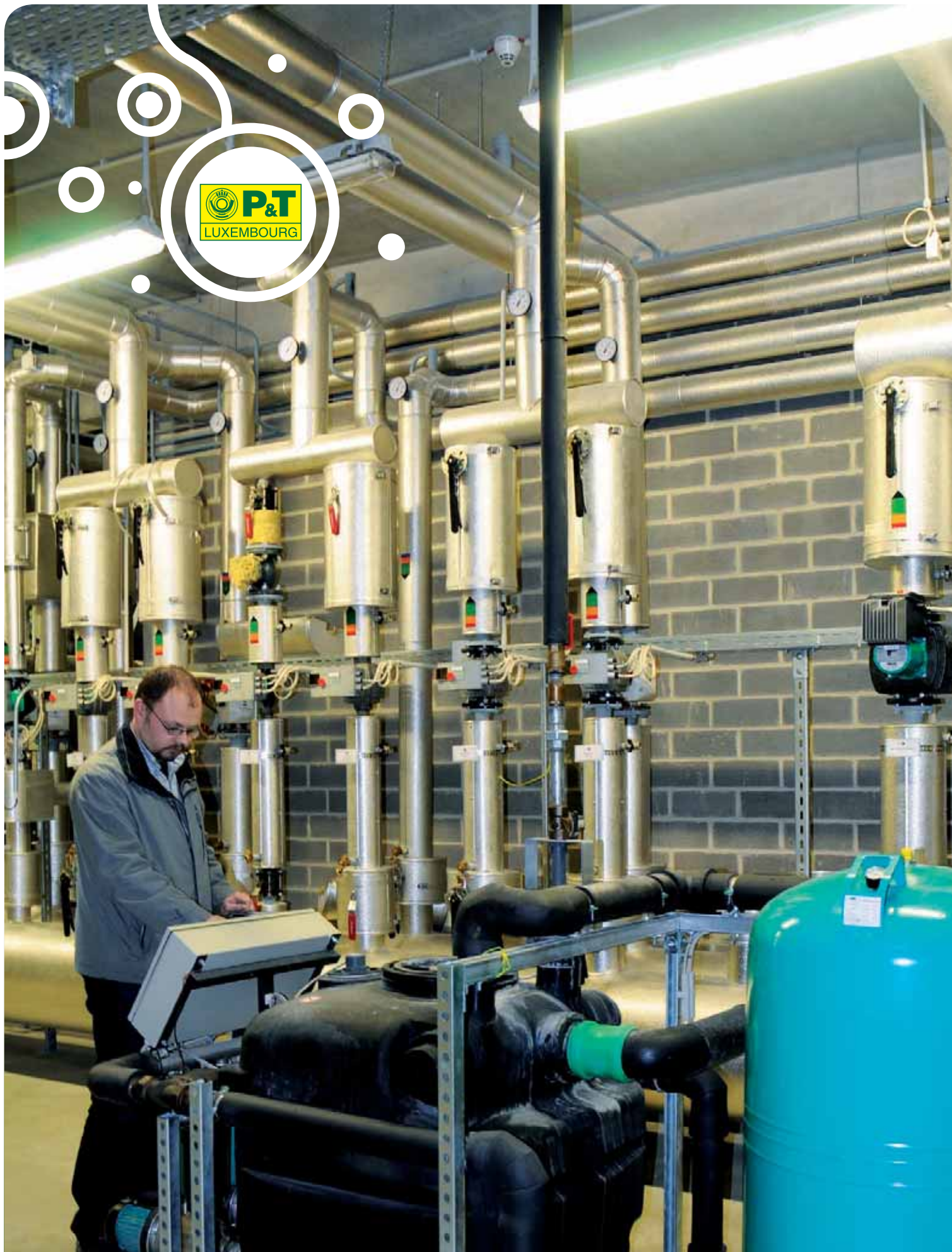
Récupération d'eau de pluie au Centre de Tri national | Bettembourg
